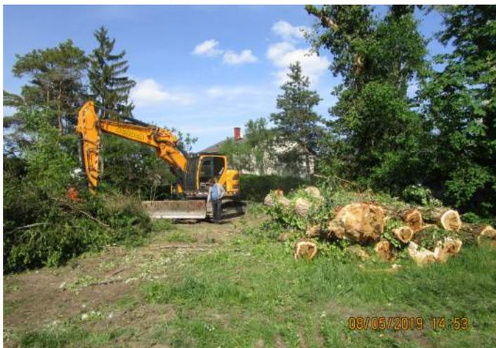
Ab 17.06.2019 werden im Bereich Gärtnerweg flussaufwärts der Stöcklbrücke die Abtragsarbeiten und Schüttmaßnahmen zur Herstellung eines Bohrpfahlplanums begonnen. Ab diesem Zeitpunkt sind Arbeiten in den benetzten Gewässerabschnitten möglich.
